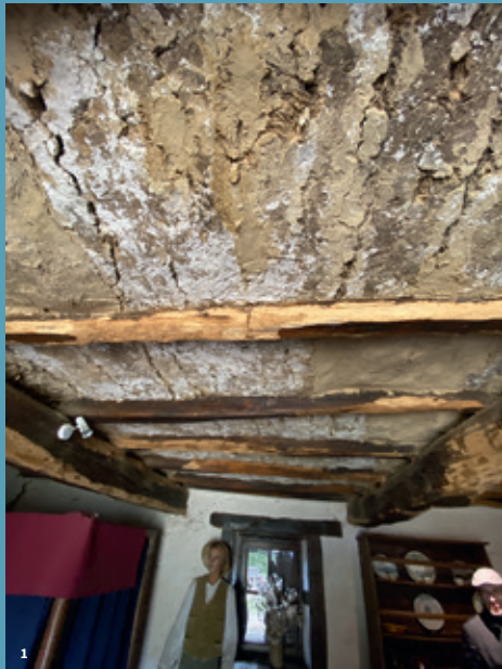
1. Détail du plafond recouvert de bousillis dans la ferme n°10 de la ligne acadienne
