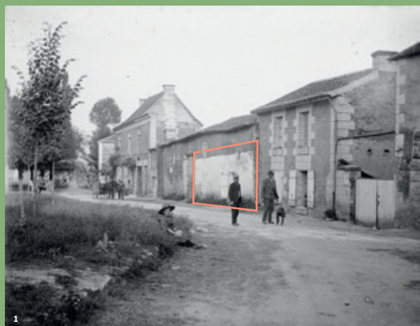
1. Bourg de Doussay, l'une des façades est enduite à mi hauteur à la chaux.
